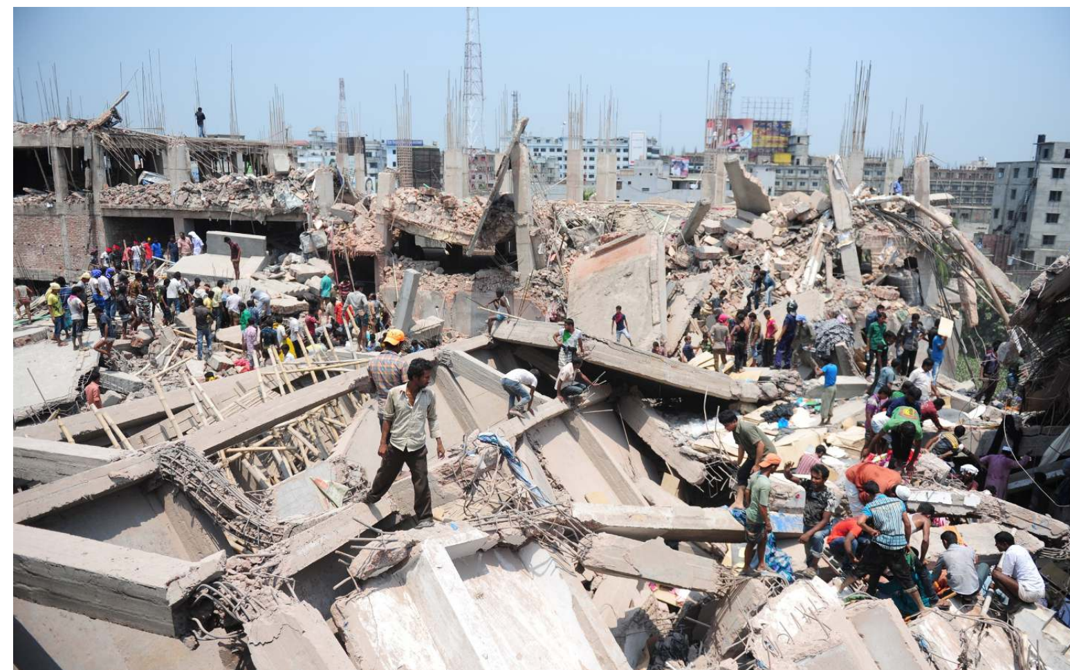
Savar (Bangladesh), le 24 avril 2013. Dans ce faubourg de Dacca, le bâtiment Rana Plaza, qui abritait plusieurs ateliers de confection travaillant pour des marques internationales de vêtements, s'est effondré le matin. 1 138 travailleurs du textile ont trouvé la mort. (AFP/Muriz uz Zaman.)
